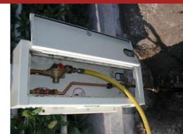
1 Flexible inox DN25, raccord MM : DN25 JSC longueur : 5 mètres.
